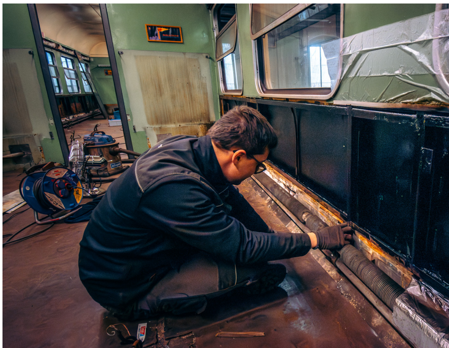
Ausbesserungen an den Rohren. (Foto: SEM Chemnitz)
