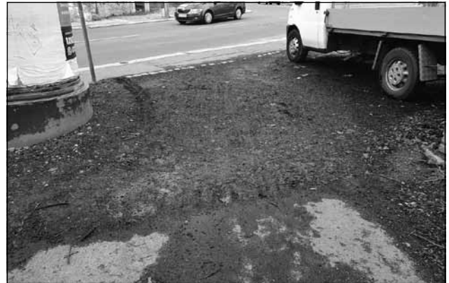
Diese unschöne Stelle an der Hilbersdorfer Straße/Emilienstraße sorgte bei Fußgängern für Unmut. Das Tiefbauamt reagierte schnell und besserte aus. Foto: Gerhard Pospischil
