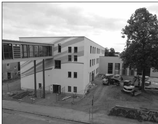
Im Außenbereich ist noch einiges zu tun.
