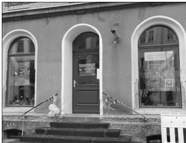
Noch mitten in der Baustelle: Im Haus Brühl 63 wurde am 1. September eine private Musikschule eröffnet.
