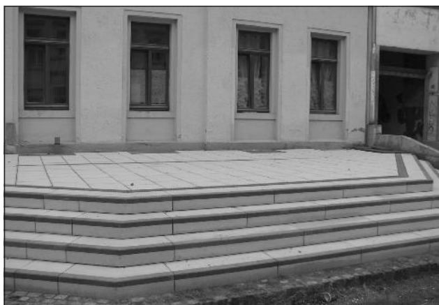
Podeste wurden barrierefrei umgebaut. Sie sind in zurückhaltenden Pastellfarben gehalten und nehmen damit die Farbe der Fassadengestaltung auf.
