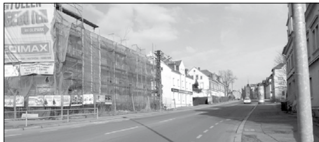
Die Bürger warten auf die Sanierung des letzten Stücks der Frankenger Straße zwischen Max-Saupe-Straße und Ortsausgang, das sich noch in einem schlechten Zustand befindet. Fotos: Hähle
