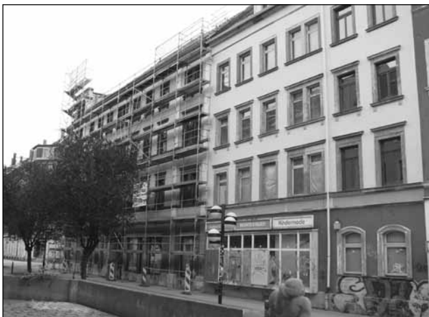
Private Eigentümer sanieren derzeit Gebäude am Brühl.
