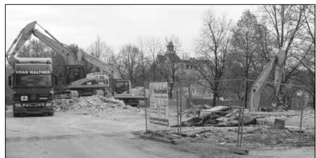
Das Doppelhochhaus an der Mühlenstraße 48/50 (GGG) ist abgerissen. Die freigewordene Fläche soll zunächst begrünt werden. Langfristig können hier wieder Neubauten (zur Karreeschließung) entstehen.
