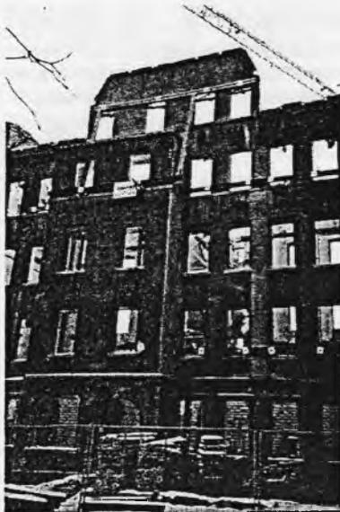
Lohrstraße 37. Die denkmalgeschützte Fassade wird originalgetreu rekonstruiert. Dahinter wird neu gebaut. Foto: Zellmer
